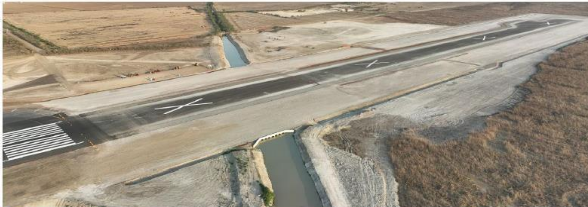
Ampliación de pista de 300 v 500 m
