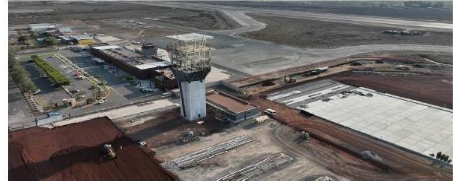
Torre de Control y su envolvente
