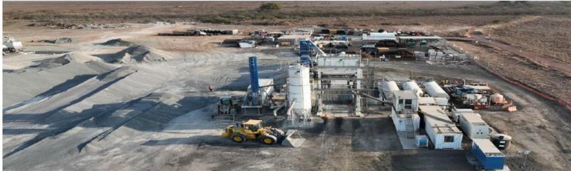
Planta de asfalto y almacén de obra
